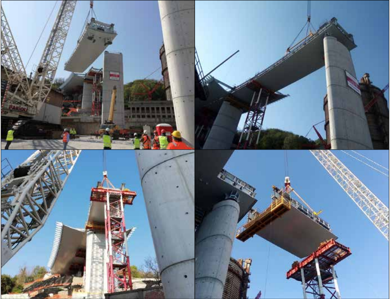
Figura 10: Sollevamento tipico in singola di un conccio con l'ausilio di torri temporanee
