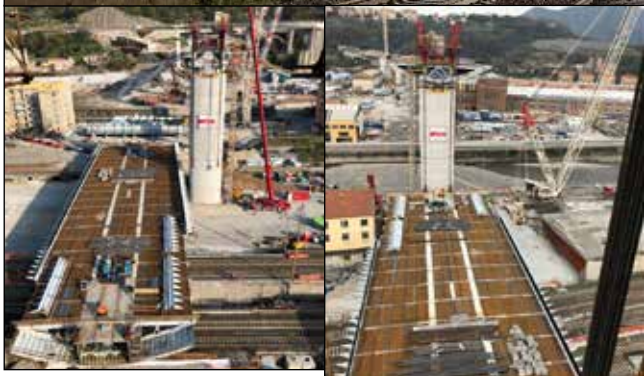
Figura 8: Movimentazione dell'impalcato 100m in corrispondenza della Ferrovia
