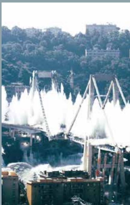
^ Figura 9: Esplosione controllate delle pile 10 e 11
