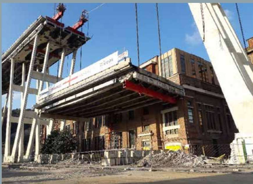
◀ Figura 2: Attività di smontaggio di una tipica trave tampone
