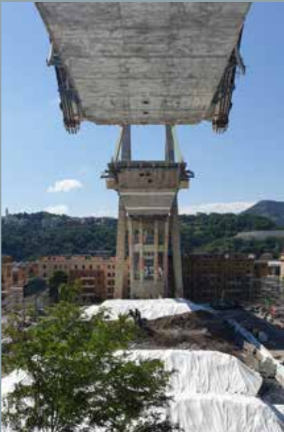
^ Figura 11: Sistema integrato tra i cinematismi di crollo e materiale deformabile a terra
