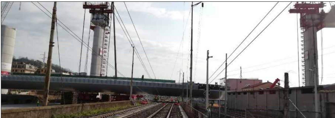
Figura 8: Movimentazione dell'impalcato 100m in corrispondenza della Ferrovia
