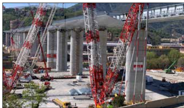
Gru operanti in cantiere per il varo delle campate da 50 metri del nuovo ponte
