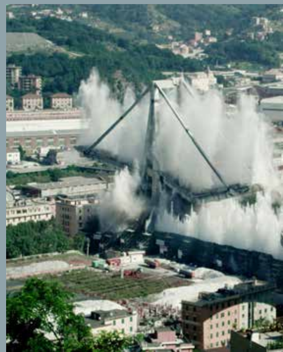
^ Figura 14: Vasche d'acqua minate strategicamente poste sull'impalcato
