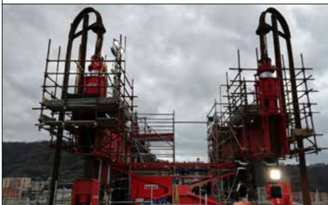
Figura 5: Strutture temporanee di supporto alla Macchina di Sollevamento "strand jack system"
