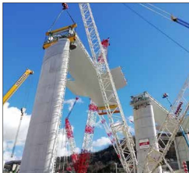
Figura 9: Sollevamento tipico in tandem della campata 50m
