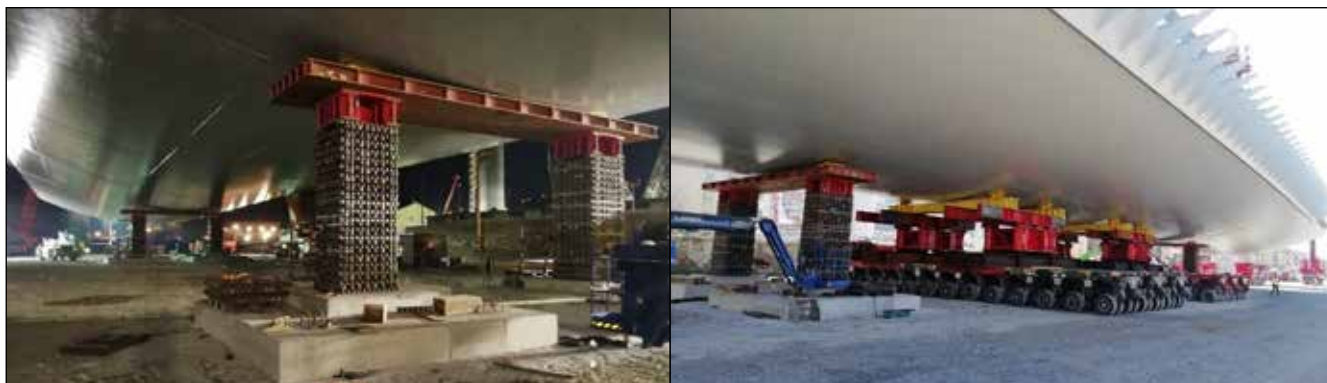
Figura 6: Sollevamento di 5m dell'impalcato e inserimento dei mezzi di trasporto
