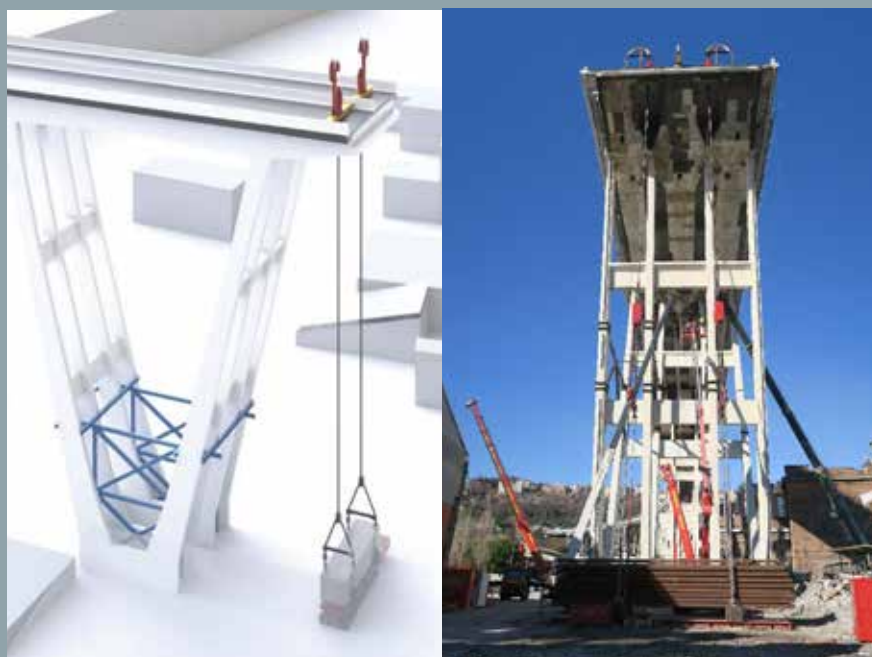
^ Figura 1: Sistema di bilanciamento della Pila 8
