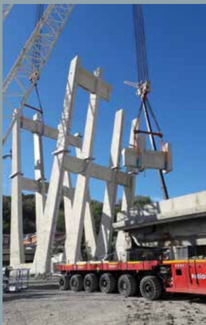
^ Figura 6: Smontaggio della pila con gru
