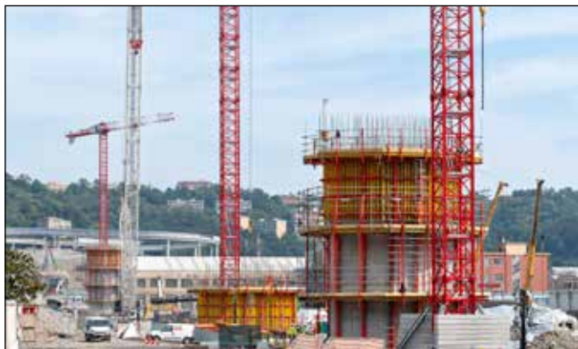
Costruzione delle pile in calcestruzzo tramite casseri rampanti
