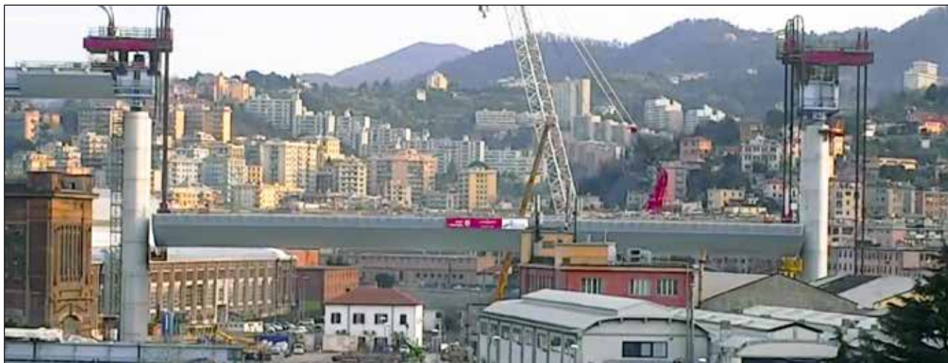
Figura 2: Sollevamento di una campata L=100m tipica con Strand Jack System
