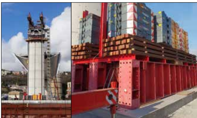
Figura 4: Sistema di bilanciamento di un conchio di pila e contrappeso
