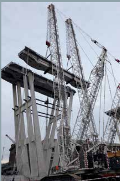
Figura 4: Smontaggio di un concio di pila con gru CC2800
