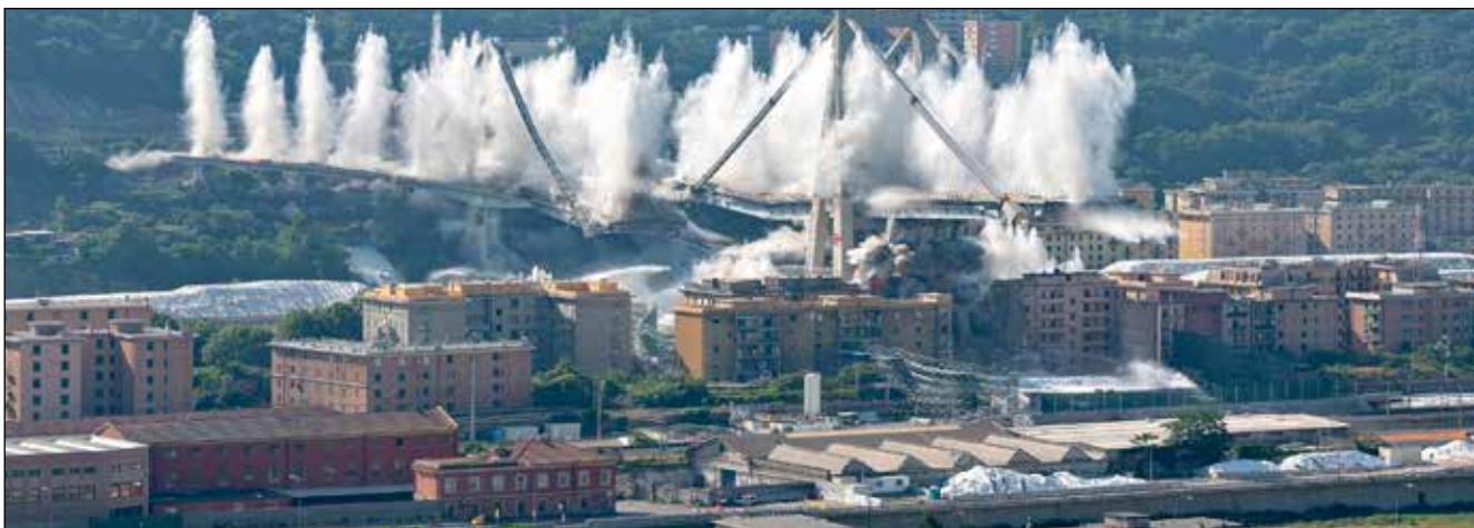
Demolizione per esplosione controllata delle pile 10 e 11 del Ponte Morandi, avvenuta il 28 giugno 2019
