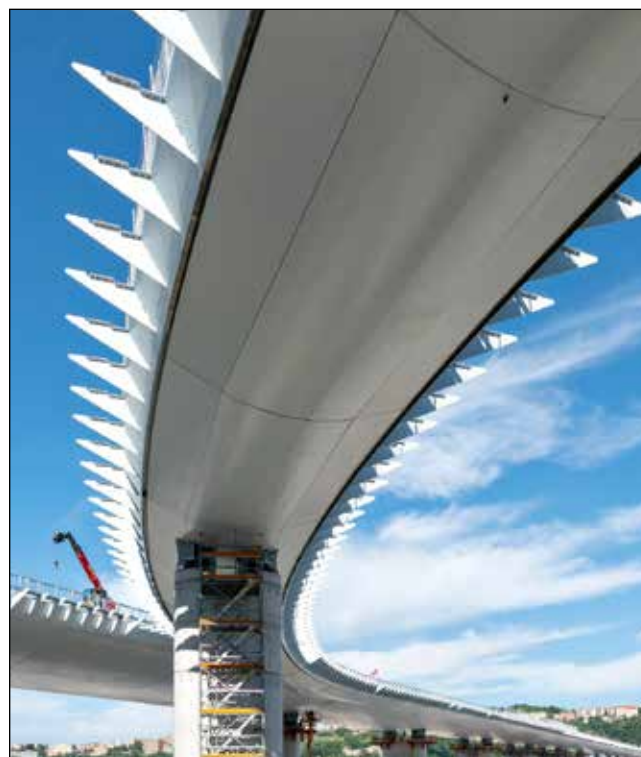
Ponte Genova San Giorgio finito con innesto sulla A7 visto dalla spalla di levante
