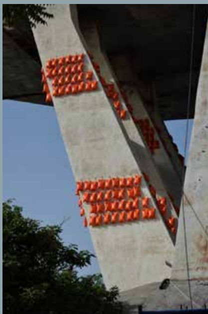
^ Figura 13: Sacchetti di pvc riempiti d'acqua e sospesi tramite funi in corrispondenza del volume minato
