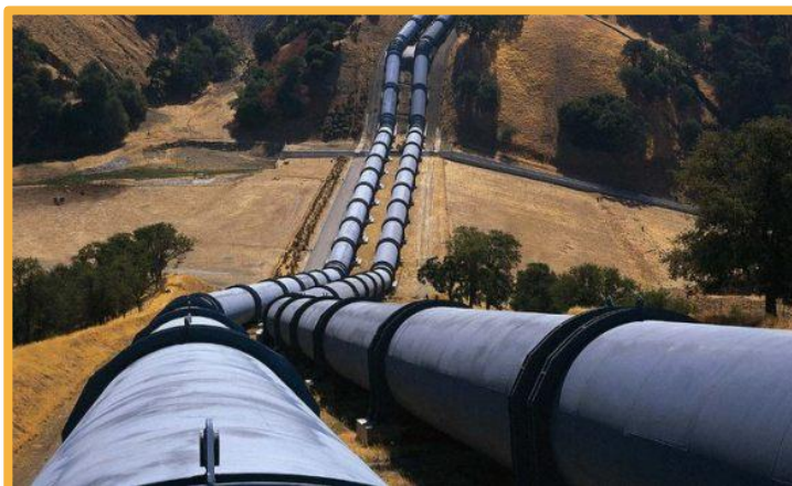
Metanodotto del Galsi (Italia - Algeria)
